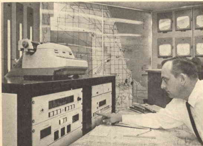
Fig. 5 - Camera di controllo di una centrale per la qualità dell'acqua.
